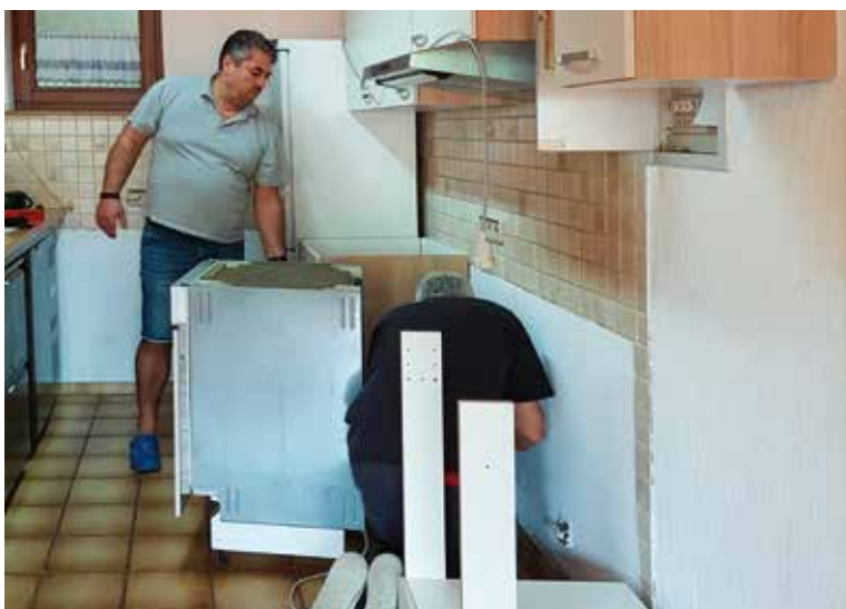
Fachmänner am Werk – die neue Küchenzeile wird eingebaut
